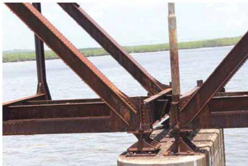
Construída em 1913, concluída em 1915, mas só inaugurada em abril de 1916, a ponte foi a primeira ligação física entre os dois lados do Rio Potengi. Com estrutura totalmente de ferro e 550 metros de extensão - com nove vãos de 50 metros e um de 70 -, sua função era permitir a passagem dos trens, facilitando o transporte entre a capital e o interior do Rio Grande do Norte, algo que até então só era possível ao atravessar
