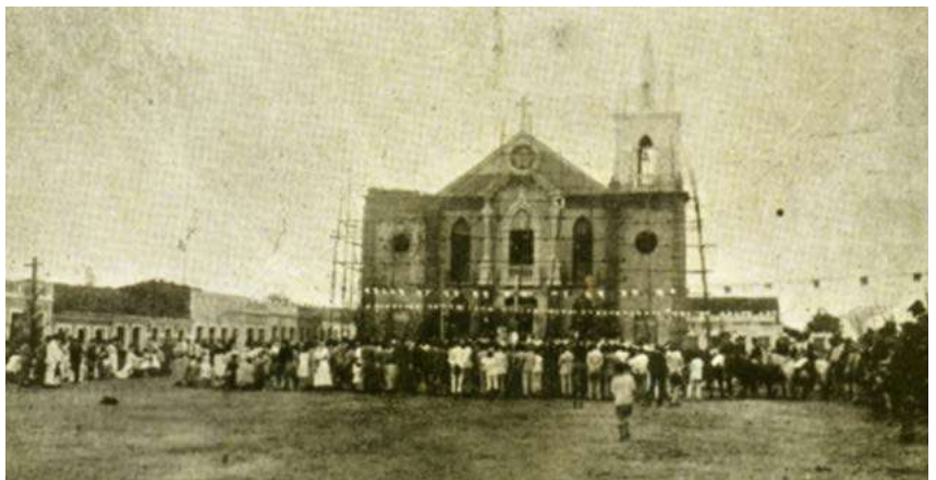
Construção da Igreja de Nova Cruz, década de 1920
